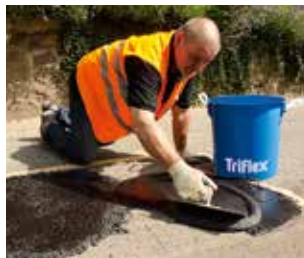
5. Material mit der Kelle verteilen und glätten.
