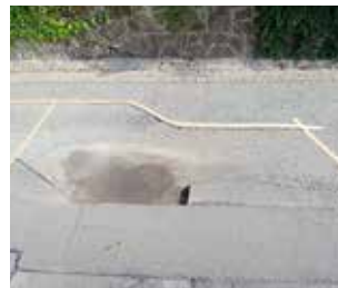
2. Den sanierungsbedürftigen Bereich abkleben.
