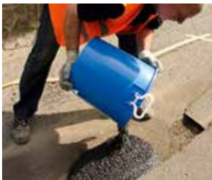
4. Angerührtes Material umtopfen und in den sanierungsbedürftigen Bereich einbringen.
