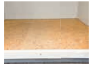
Isolierter Boden mit OSB-Platte
